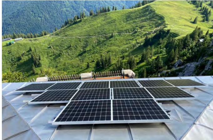
Neue Photovoltaikmodule werden angebracht // MICHL LUDWIG
