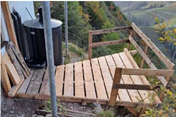
Perfekte Plattform und saubere Zimmererleistung zum provisorischen Abstellen des Tanks // OTTO PARZHUBER
