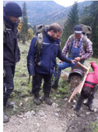
Verteilung von Feinmaterial im 2. Arbeitsgang am Sieblsteig
