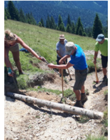
Wegsanierung oberhalb der Ableitenalm
