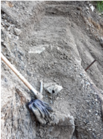
Behebung Winterschaden in der Wolfsschlucht
